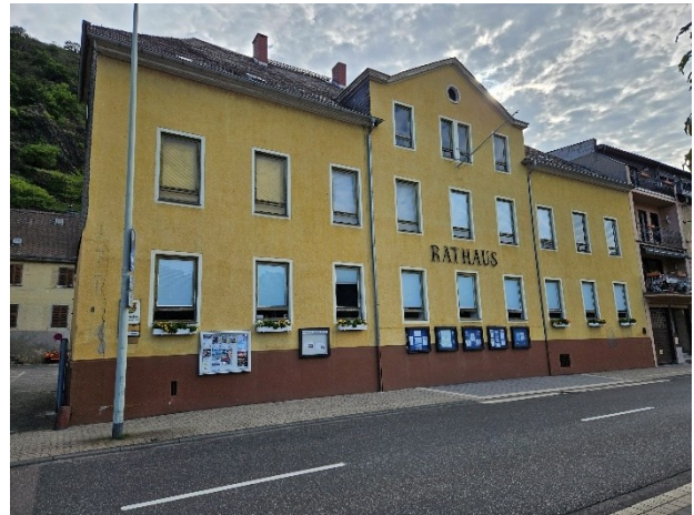
Das alte Rathaus von St. Goarshausen (2025) war nicht nur Amtssitz, sondern beherbergte auch die Dienstwohnung des Stadtbürgermeisters in der Zeit von 1925-1937 (Bild: Martin Strohmeyer)
